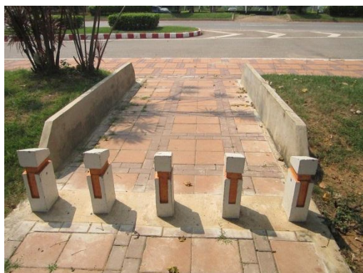
บริเวณประตูฝั่งบึงสีฐาน
