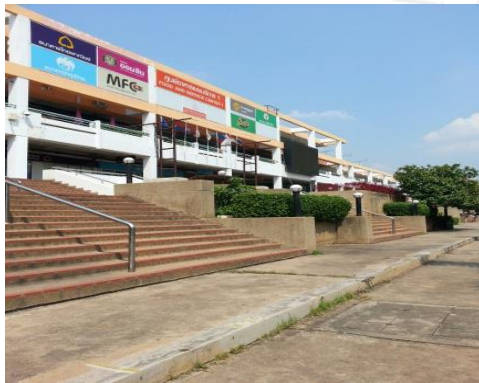
ศูนย์อาคารคอมพิวเตอร์
