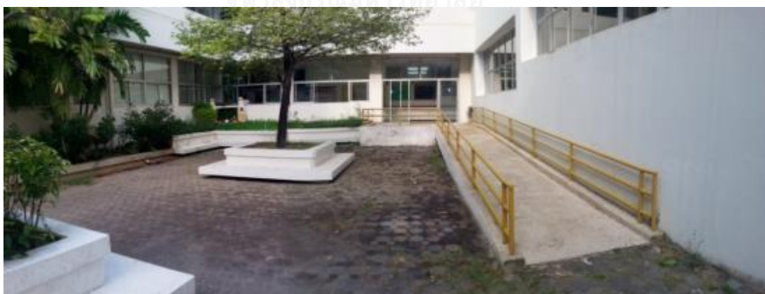
ภาพที่ 145 ทางลาด, ราวจับ และการเปลี่ยนระดับพื้นภายนอกโครงการ
