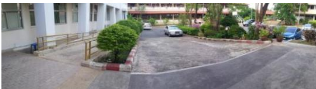
ภาพที่ 39 ทางลาดด้านข้างสำหรับคนเดิน และรถยนต์ หน้าอาคารอำนวยการ
