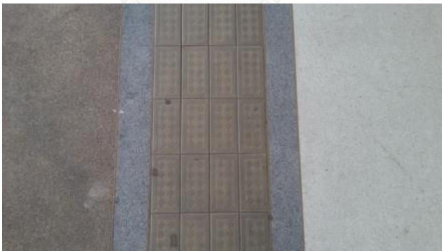
ภาพที่ 16 บริเวณทางเข้า – ออกอาคาร
