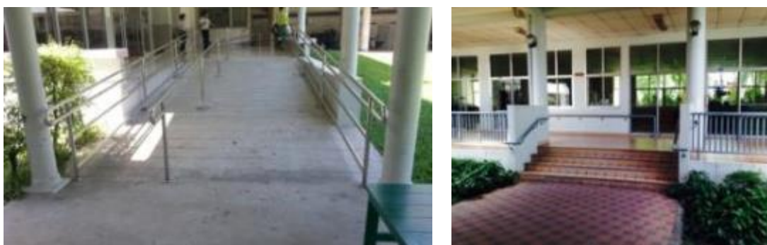
ภาพที่ 9 ทางลาด และบันไดพร้อมราวจับ
