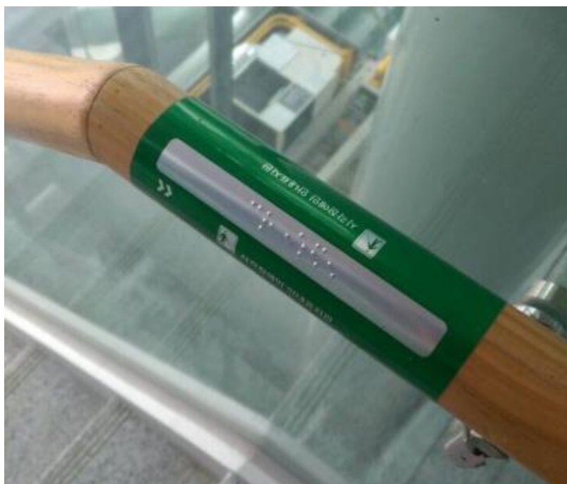
ภาพที่ 146 ราวจับ และการติดตั้งอักษรเบรลล์
