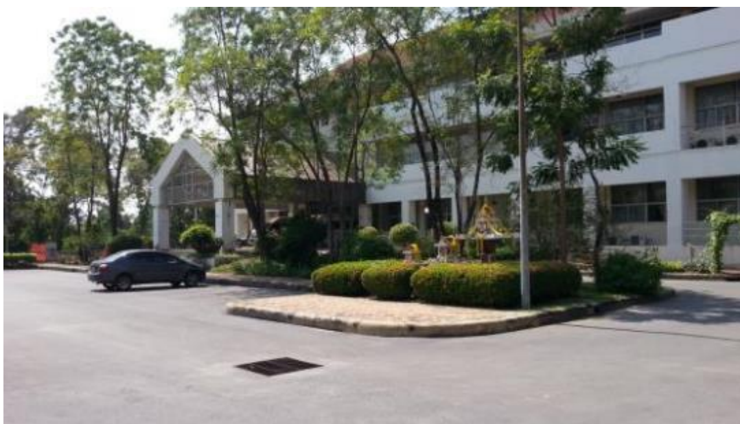
ภาพที่ 37 ที่จอดรถยนต์หน้าอาคารอำนวยการ
