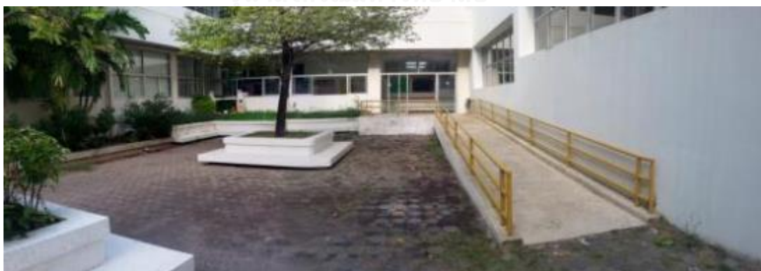
ภาพที่ 47 ทางลาดภายนอกอาคารอำนวยการ
