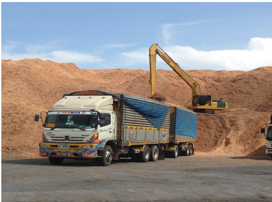
ภาพที่ 5.3 รถขุดตัก (Excavator) ตักสินค้าจากรถทางไกลขึ้นลานกอง
