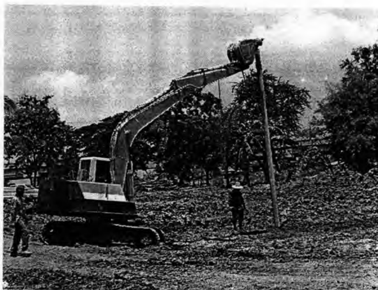
รูปที่ 1.2 วิธีการตอกเสาเข็มโดยการประยุกตใช้เครื่องจักรขุดดิน
