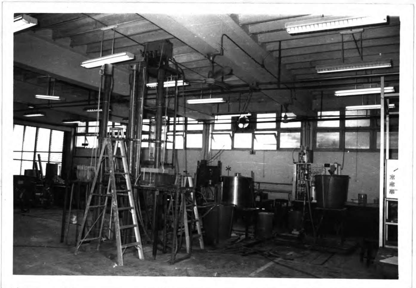
ภาพที่ 3.3 การติดตั้งระบบกรองน้ำในห้องปฏิบัติการของภาควิชาวิศวกรรมสุขาภิบาล
