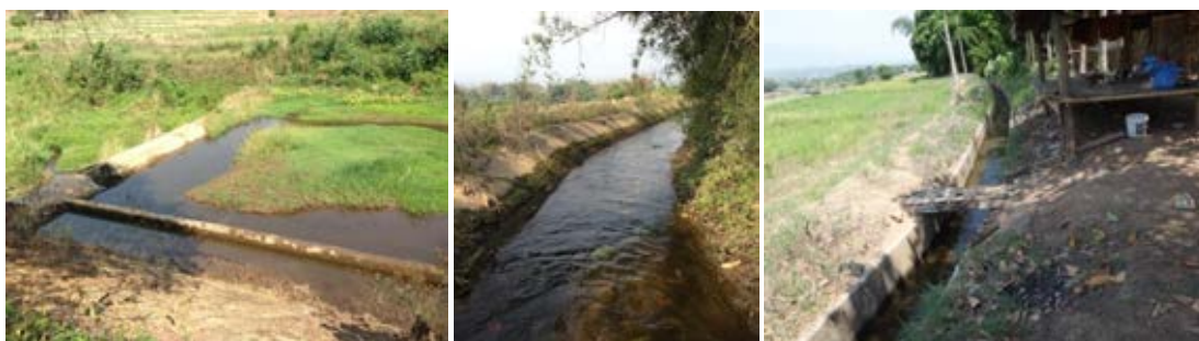
ภาพที่ 5.14 ลักษณะของฝายน้ำล้นและลำเหมือง
