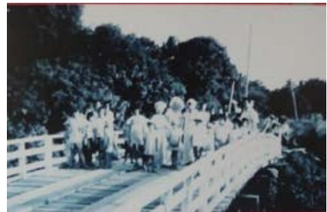
สะพานไม้ข้ามแม่น้ำปายจากเวียงเหนือ
