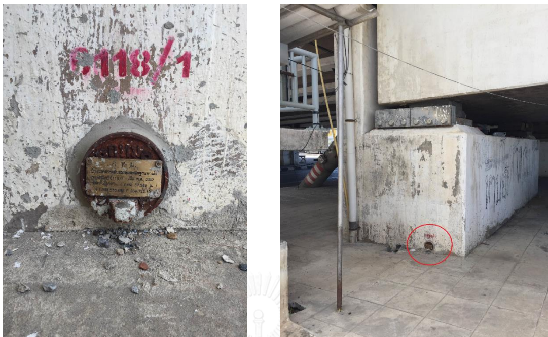
รูปที่ 3.9 ลักษณะหลุมระดับที่เป็นแบบชนิดแวนที่ติดอยู่กับสิ่งก่อสร้าง โดยในรูปเป็นหลุม กทม.682 โดยสกัดฝังแวนไว้กับคอนกรีตม่อสะพานพระนั่งเกล้าฯ ฝั่งตะวันตก ใกล้กับทางบันไดขึ้นลง
