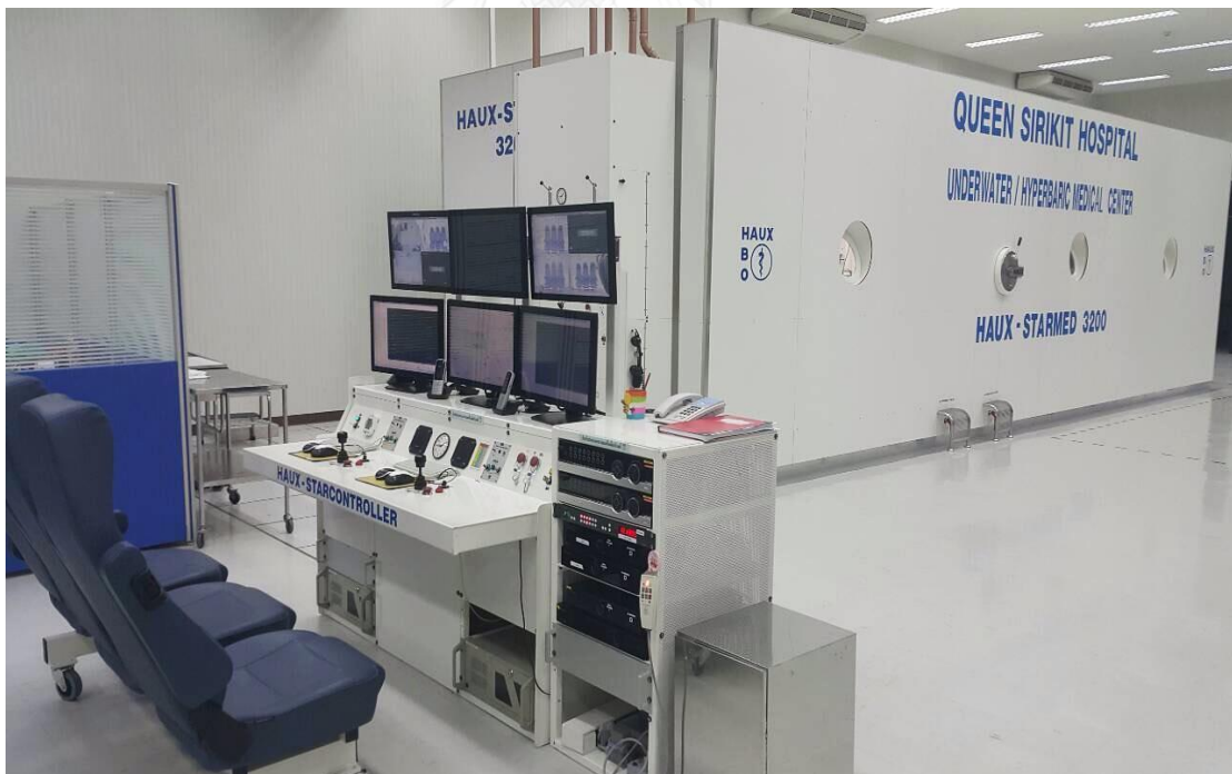
ภาพที่ 8 ห้องปรับแรงดันบรรยากาศสูง ชนิดหลายคน (Multiplace chamber) ขนาด 18 ที่นั่ง (โรงพยาบาลสมเด็จพระนางเจ้าสิริกิติ์)
