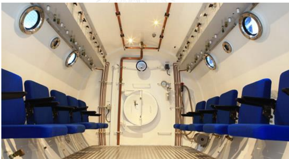
ภาพที่ 6 ลักษณะภายในห้องปรับแรงดันบรรยากาศสูง ชนิดหลายคน (Multiplace chamber) (โรงพยาบาลศิริรฎกเกิด)
