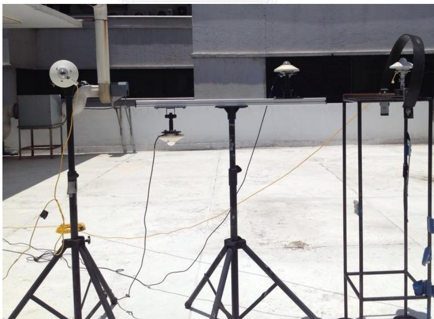
รูปที่ 5.17 การติดตั้งอุปกรณ์เพื่อหาสัดส่วนของรังสีแสงอาทิตย์แบบกระจายที่มาจากท้องฟ้าและพื้นดินบริเวณดาดฟ้าของตึกโคลัมโบ
