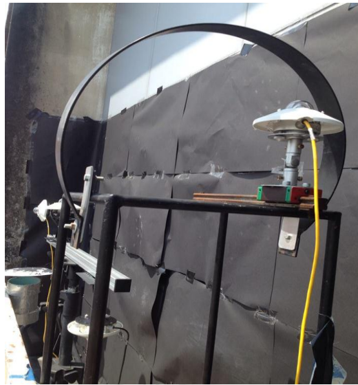
รูปที่ 5.21 การติดตั้งอุปกรณ์การวัดและการจัดเตรียมพื้นที่บริเวณระเบียงของห้องทดลอง
