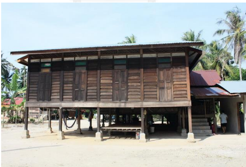
ภาพที่ 11 เรือนฝากระดานใต้ถุนโล่ง อายุกว่า 50 ปี ของนางคำ ไชยมณี
