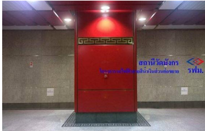
เสากายในสถานีหุ้มด้วย Matal clading เจดสีแดงและลายจีน
