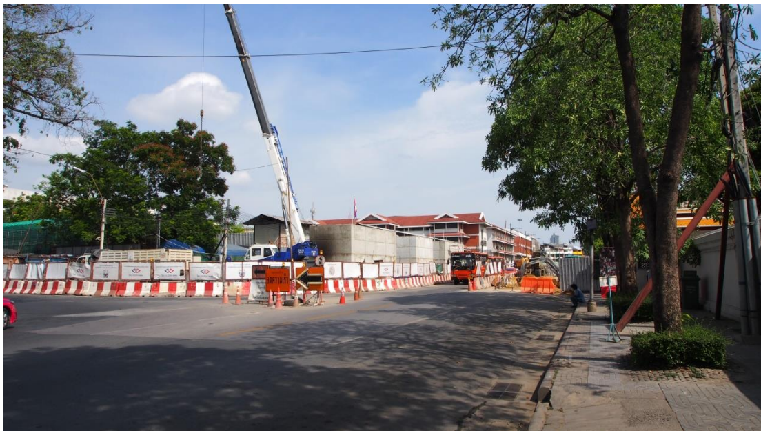
ภาพที่ 7 - 1 บริเวณพื้นที่ด้านทิศใต้ของพื้นที่ศึกษาย่อยที่ 1 (สนามหลวง) ที่มีการก่อสร้างรถไฟฟ้า ที่มา : ผู้วิจัย
