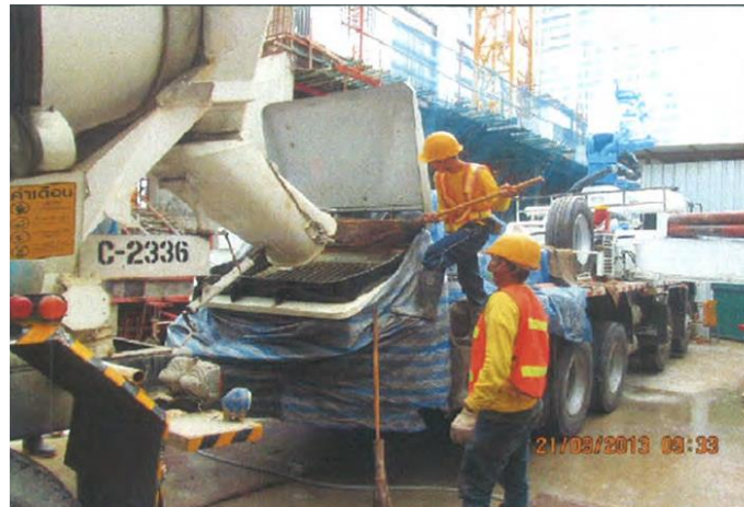
ภาพที่ 14 แสดงการล้างรถก่อนออกจากโครงการ ที่มา : รายงานประจำเดือนกันยายน 2013 โครงการ D
