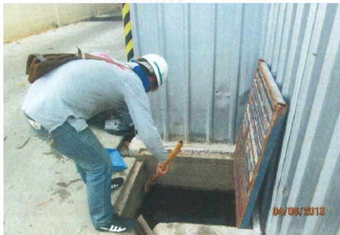
ภาพที่ 21 แสดงการทำความสะอาดบ่อดักตะกอน ที่มา : รายงานประจำเดือนมิถุนายน 2013 โครงการ D
