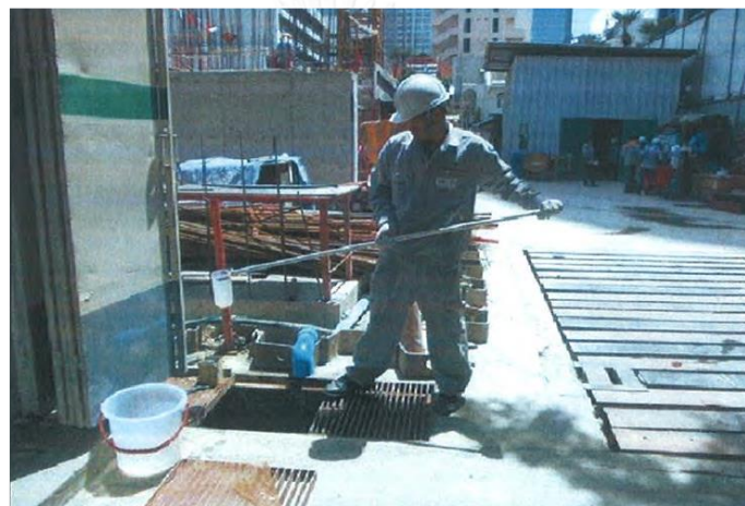
ภาพที่ 18 แสดงรูปภาพการตรวจสอบน้ำเสียจากการก่อสร้าง ที่มา : รายงานประจำเดือนกันยายน 2013 โครงการ D
