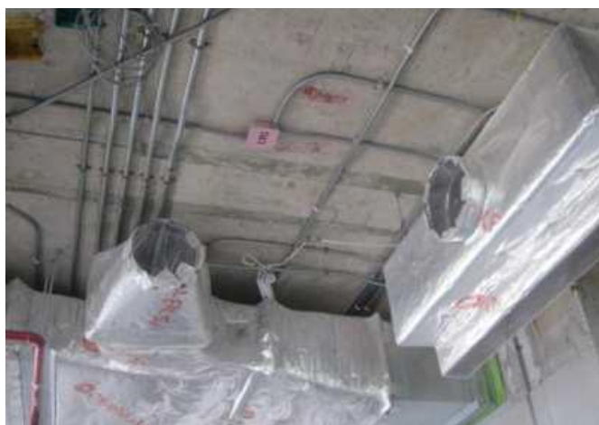
ภาพที่ 30 แสดงการหุ้มท่อแอร์ป้องกันฝุ่น ที่มา : IAQ report โครงการ B
