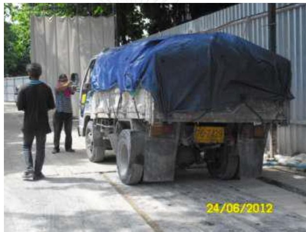
ภาพที่ 11 แสดงการปิดคลุมรถบรรทุกก่อนออกจากโครงการ ที่มา : รายงานประจำเดือนมิถุนายน 2012 โครงการ B
