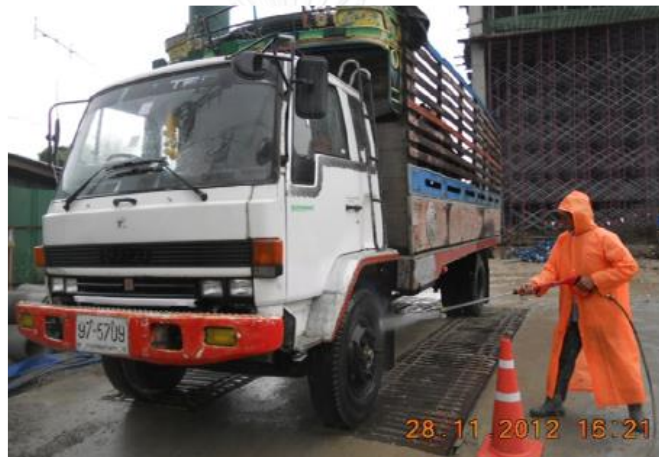
ภาพที่ 28 แสดงการทำความสะอาดล้อรถก่อนออกจากโครงการ ที่มา : รายงานประจำเดือนพฤศจิกายน 2012 โครงการ F
