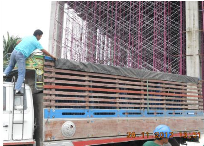
ภาพที่ 27 แสดงการปิดคลุมรถบรรทุกก่อนออกจากโครงการ ที่มา : รายงานประจำเดือนพฤศจิกายน 2012 โครงการ F
