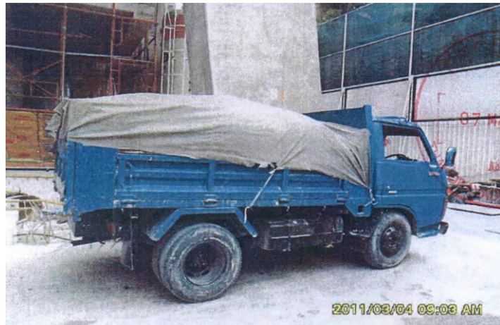
ภาพที่ 5 แสดงรูปภาพการคลุมรถบรรทุกก่อนออกจากโครงการ ที่มา : รายงานประจำเดือนมีนาคม 2011 โครงการ A
