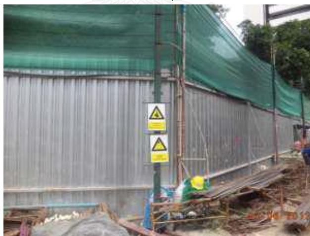
ภาพที่ 9 แสดงการติดตั้งกำแพงกันฝุ่น ที่มา : รายงานประจำเดือนมิถุนายน 2012 โครงการ B
