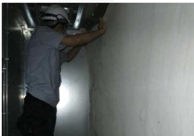
ภาพที่ 31 แสดงการติด filter MERV 8 ที่มา : IAQ report โครงการ B
