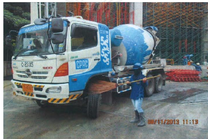
ภาพที่ 15 แสดงการทำความสะอาดล้อรถก่อนออกจากโครงการ ที่มา : รายงานประจำเดือนพฤศจิกายน 2013 โครงการ D
