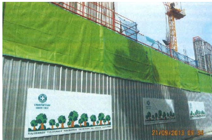
ภาพที่ 17 แสดงรูปภาพรั้วป้องกันฝุ่น ที่มา : รายงานประจำเดือนกันยายน 2013 โครงการ D
