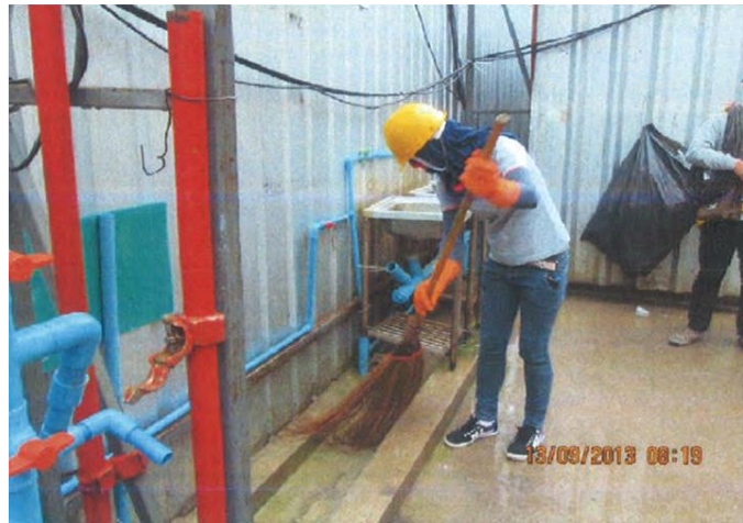
ภาพที่ 20 แสดงการทำความสะอาดรางระบายน้ำ ที่มา : รายงานประจำเดือนกันยายน 2013 โครงการ D
