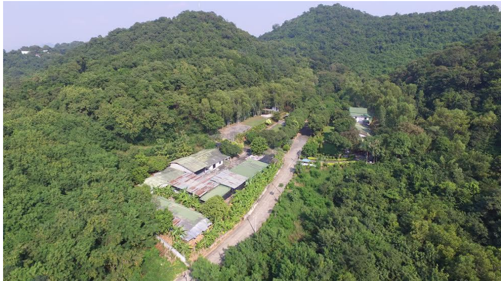
รูปที่ 4.1 ภาพถ่ายบนอากาศบริเวณบ้านพักคนงาน
