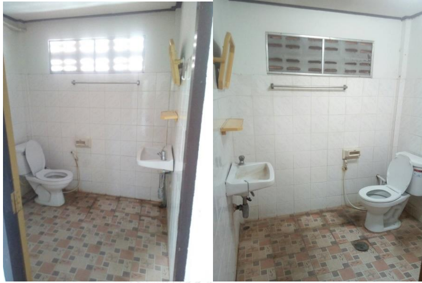
รูปที่ 4.3 ภาพห้องน้ำในบ้านพัก
