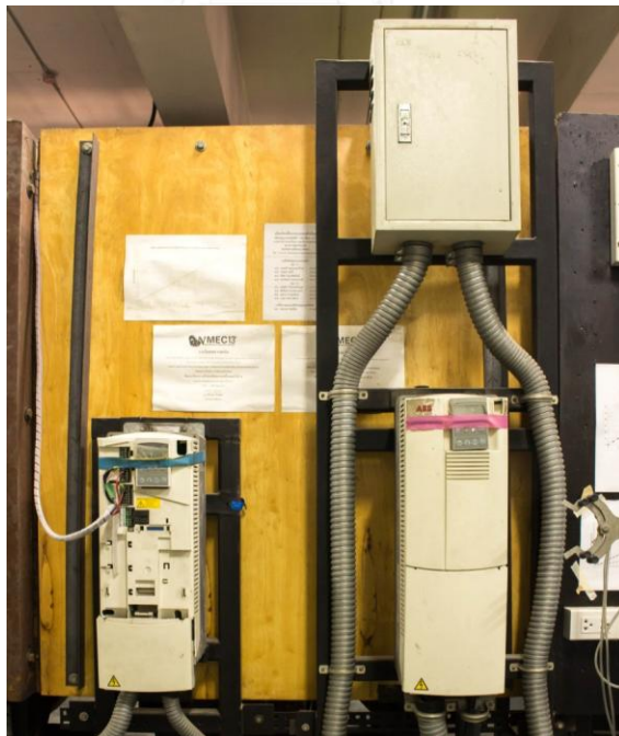
รูปที่ 4.4 เครื่องแปลงความถี่ไฟฟ้าหรือ inverter (ABB™ model ACS401002032 ขนาด 50 Hz ค่าความละเอียดเท่ากับ 0.1 Hz)
