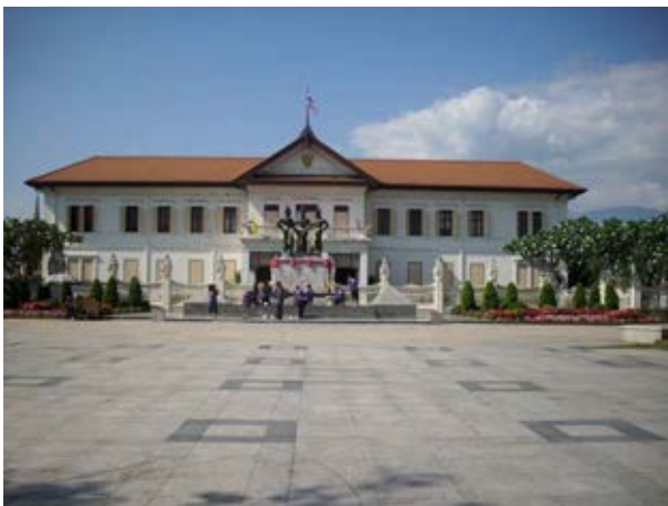
ภาพที่ 4.32 การใช้ประโยชน์อาคารประเภทสาธารณูปโภค สาธารณูปการ ถนนราชดำเนิน
