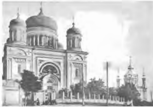
โบสถ์ดีเสียดิน (Десятинная церковь) ถูกสร้างขึ้นใหม่ในปี ค.ศ. 1842 และถูกรื้อถอนครั้งที่ 2 ในปี ค.ศ. 1928 ตามมติของพรรคคอมมิวนิสต์ ที่มา: http://velannikova.livejournal.com/214402.html
