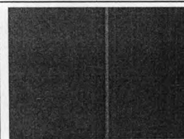
รูปภาพ 5.29 แสดงลักษณะของรอยต่อที่แต่งเสร็จเรียบร้อย (ทิ้งไว้ประมาณ 3-4 ชม. ให้แห้งสนิท)
