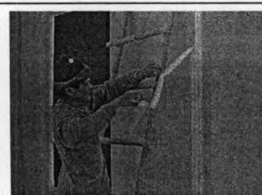
รูปภาพ 5.28 แสดงการลอกเทปกาวยออกหลังจากปาดแต่ง Polyurethane เรียบร้อยแล้ว
