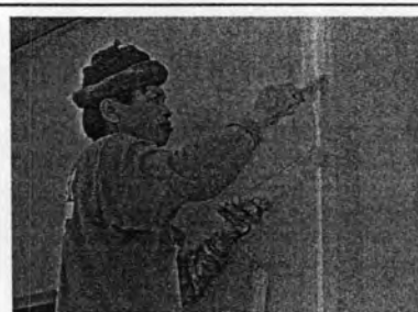
รูปภาพ 5.26 แสดงการปาดแต่งรอยต่อด้วยเกรียงสามเหลี่ยมครั้งที่ 1 เพื่อให้รอยต่อเรียบได้ระนาบกับผนัง
