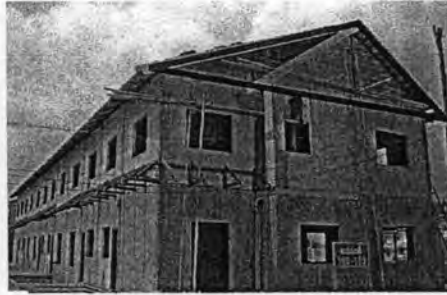
รูปภาพ 5.7 แสดงพื้นที่บริเวณหน้าบันด้านจั่วของอาคารประเภททาว์นเฮาส์ที่ต้องอาศัยช่างฝีมือในการก่อฉาบ
