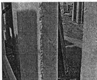
รูปภาพ 5.30 .แสดงชั้นผนังสำเร็จรูปของบริษัทเอเทคแสดนดาร์ตจำกัดที่มีการฝังเหล็กเอาไว้ในขั้นตอนการผลิตเพื่อจะใช้สำหรับรอยต่อแบบเปียก (ลักษณะของขอบชั้นผนังสำเร็จรูปเป็นขอบเรียบแบบไม่มีกนุญแฉับแรง (Shear key))
