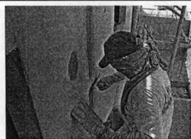
รูปภาพ 5.20 แสดงการฉาบแต่งผิวบริเวณรอยต่อระหว่างผนังด้วยปูนแต่งผิว
