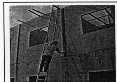
รูปภาพ 5.40 แสดงการกะเทาะปูนในส่วนที่เกินออกจากแนวที่กำหนด
