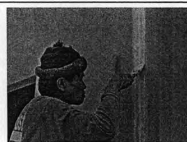
รูปภาพ 5.27 แสดงการปาดแต่งรอยต่อด้วยเกรียงสามเหลี่ยมครั้งที่ 2 เพื่อให้รอยต่อเรียบได้ระนาบกับผนัง
