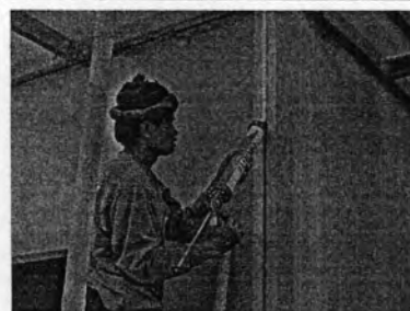
รูปภาพ 5.25 แสดงลักษณะการเก็บรอยต่อด้วย Polyurethane
