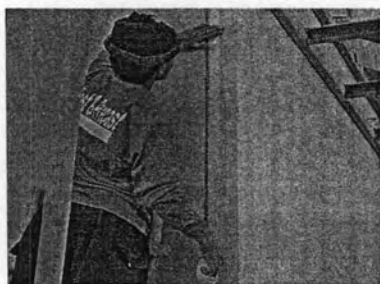
รูปภาพ 5.24 แสดงการติดเทปกาวยัง 2 ซ้ำงเพื่อกำหนดขอบเขตและกันเปื้อน
