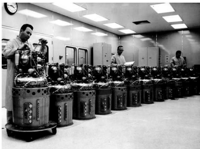
รูปที่ 2.5 ระบบเซลล์เชื้อเพลิงของยานอวกาศอะพอลโลซึ่งพัฒนาโดยบริษัท United Technologies Corp. (UTC) [2]
