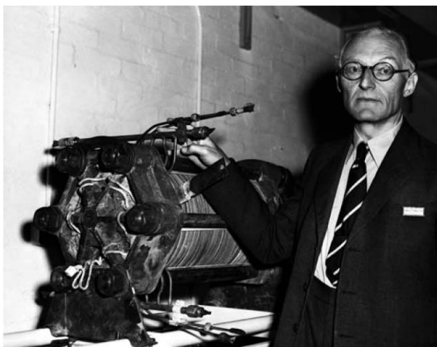
รูปที่ 2.4 เซลล์เชื้อเพลิงขนาด 6 กิโลวัตต์ ที่พัฒนาขึ้นโดยฟรานซิส เบคอน ในปีค.ศ.1959 [2]
