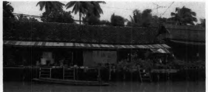
หลังคาเรือนแถวทรงจั่วผสมปั้นหยา มุงด้วยกระเบื้องดินเผาหรือสังกะสี
