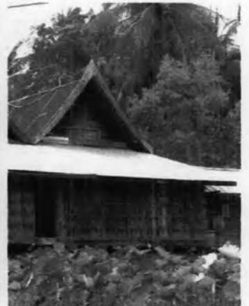
ลักษณะฝาเรือนเป็นฝาขัดแตะที่ยังมีให้พบเห็น
