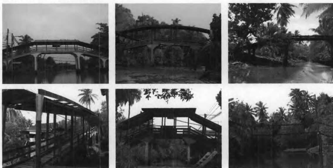
รูปที่ 6.30 แสดงสะพานข้ามคลองในชุมชน
