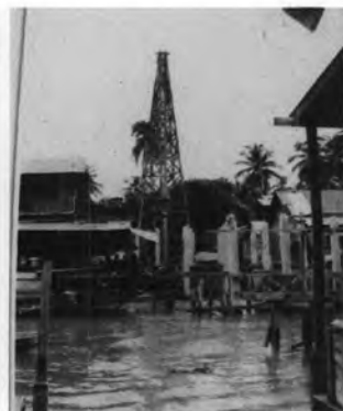
สร้างสะพานปูนแทนสะพานไม้เดิม
