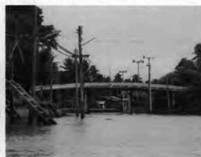
สะพานข้ามคลองบางน้อยบริเวณวัดไทร
