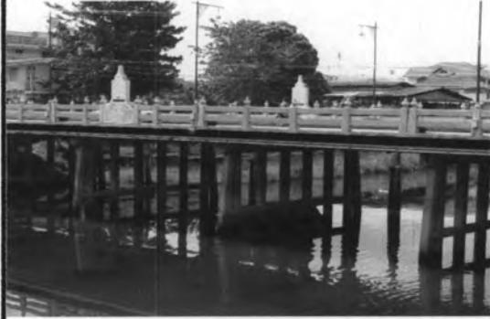
(ฎ) สะพานเทศบาลเมืองเพชรบุรี (st.11)
