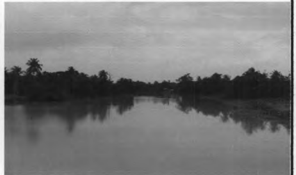
(ฉ) สะพานวัดท่าซึก (st.6)
