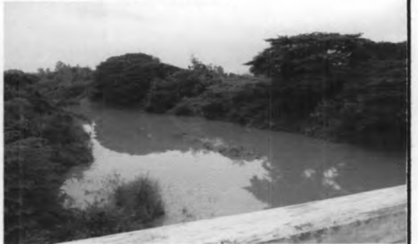
(ณ) สะพานสระขายนนท์ (st.16)
