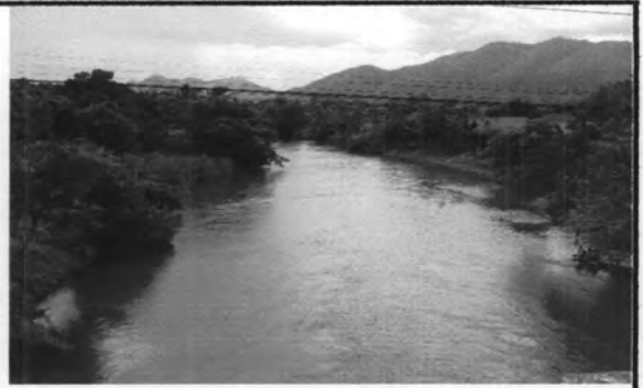
(ข) สะพานท้ายเขื่อนแก่งกระจาน (st.2)
