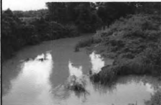
(ฒ) สะพานบ้านท่าคะคร้อ (st.15)
