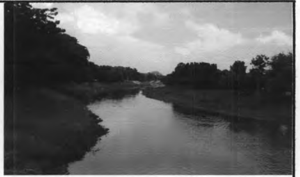
(ญ) สะพานอูรุพงษ์ (st.10)
