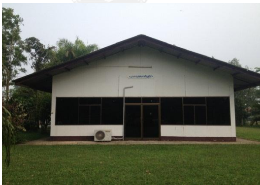
ภาพที่ 84 อาคารอเนกประสงค์
