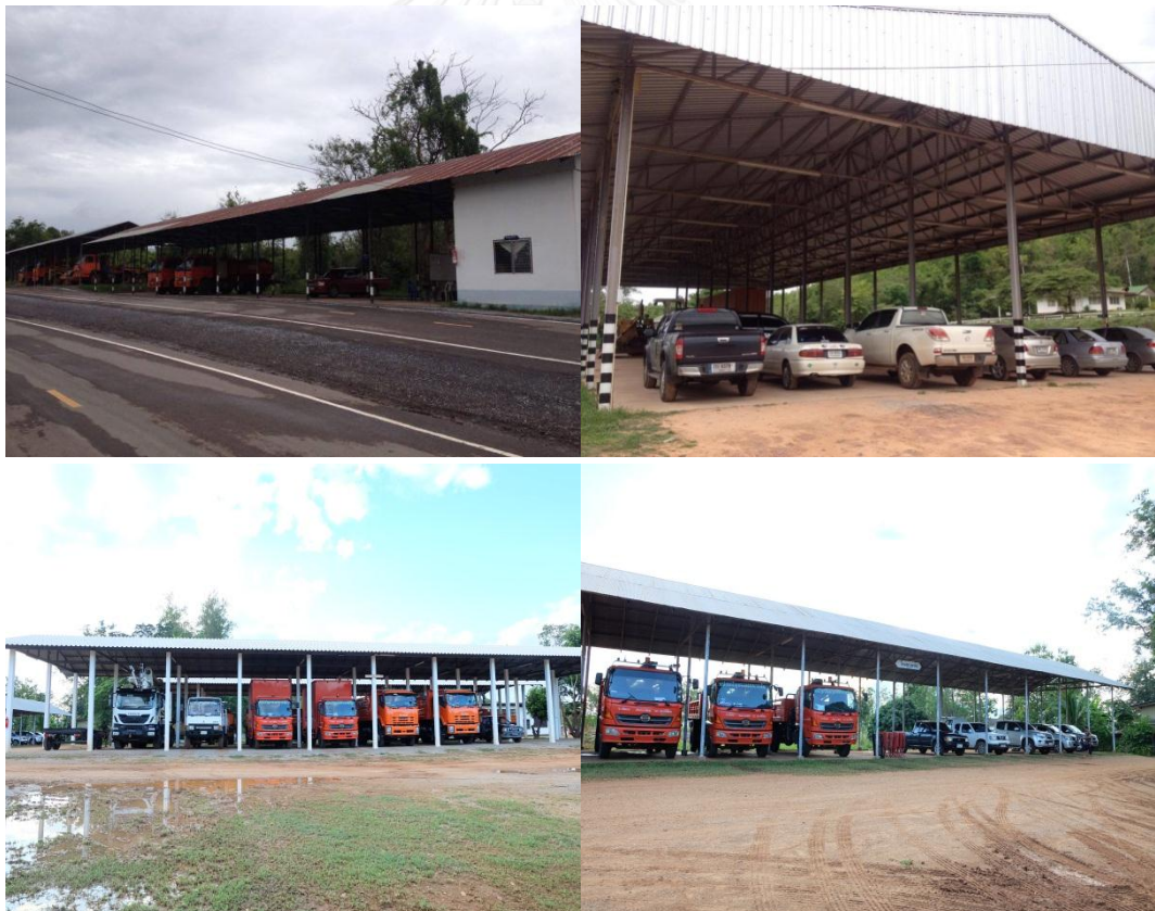
ภาพที่ 94 อาคารจอดยานพาหนะของหน่วย
