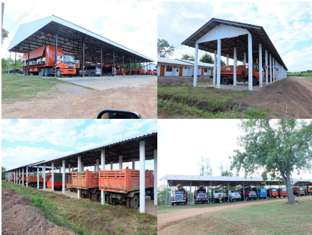
ภาพที่ 62 อาคารจอดยานพาหนะของหน่วย
