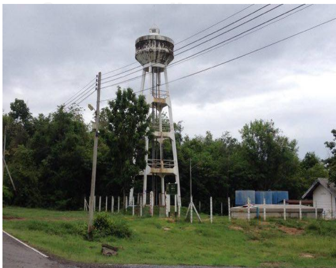
ภาพที่ 97 หอถังน้ำ
