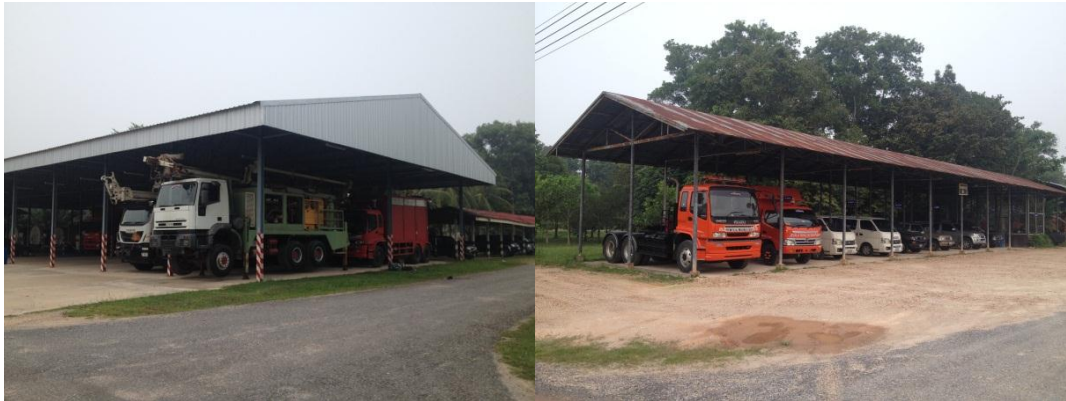
ภาพที่ 79 อาคารจอดยานพาหนะของหน่วย
