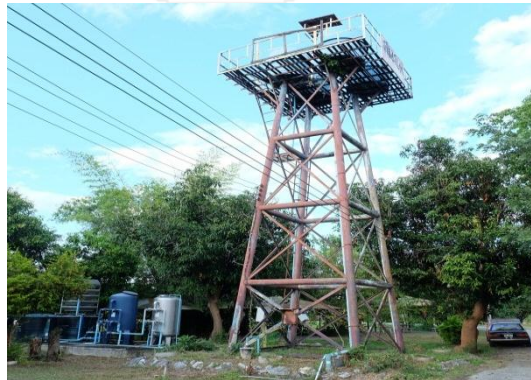
ภาพที่ 65 ท่อถังน้ำ
