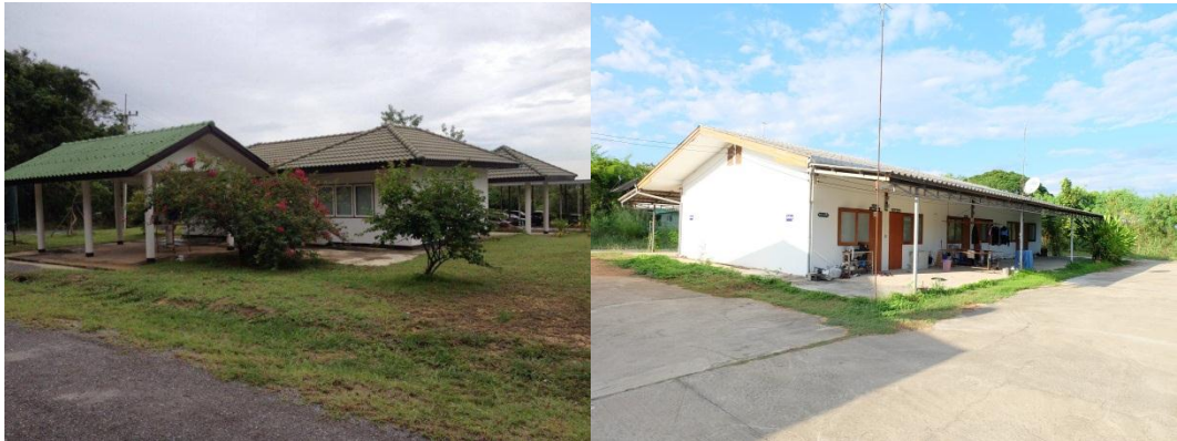
ภาพที่ 90 อาคารบ้านพักข้าราชการและคนงานของหน่วย
