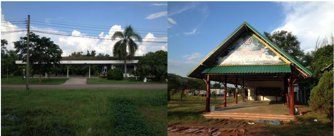
ภาพที่ 46 อาคารอเนกประสงค์
