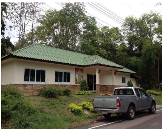
ภาพที่ 99 อาคารอเนกประสงค์
