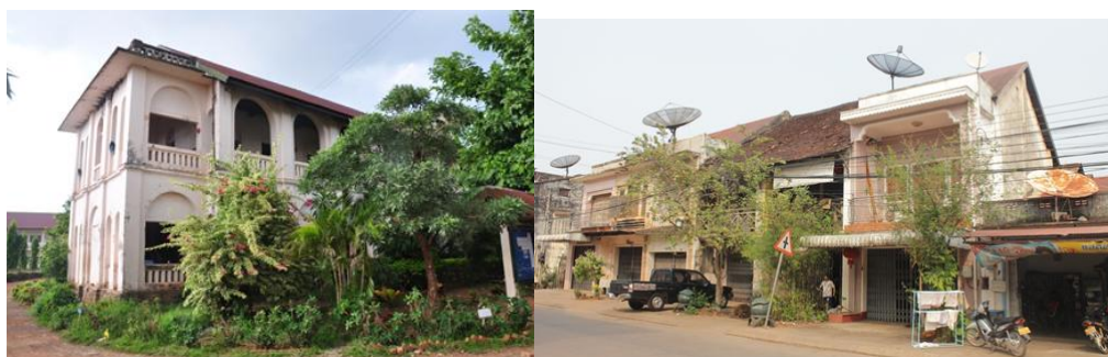
ภาพที่ 50 สถานภาพอาคารทั่วไป
