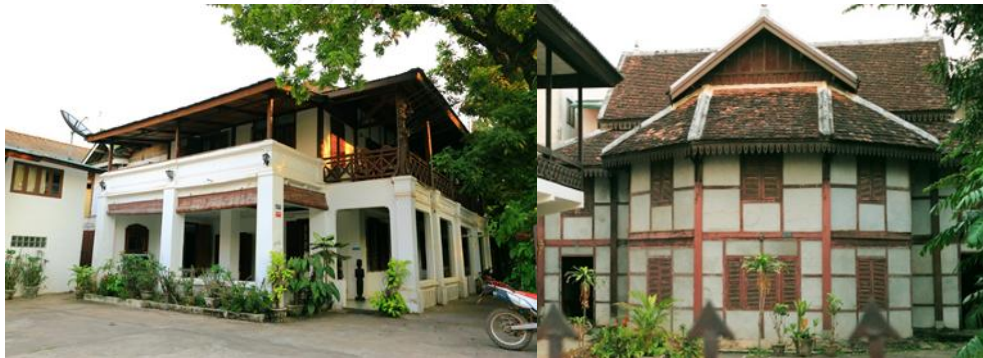
ภาพที่ 37 รูปแบบอาคารอาคารลาวอาณานิคม
