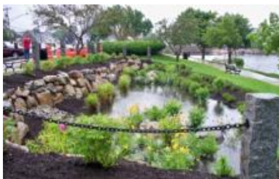
ภาพที่ 2.6 การออกแบบการกักเก็บด้วยพืช (Bioretention Cells)
