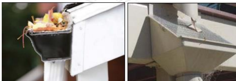
ภาพที่ 6.4 ตะแกรงกรองน้ำก่อนเข้าถังเก็บน้ำ
