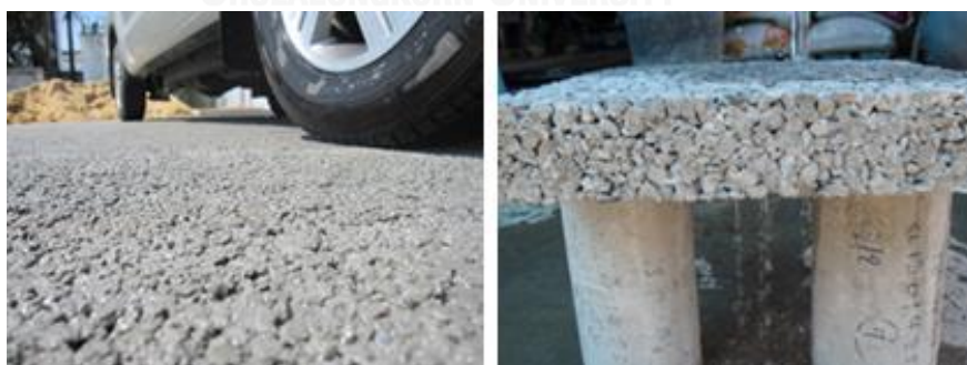
ภาพที่ 6.7 พื้นี่คอนกรีตน้ำสามารถซึมผ่านได้
