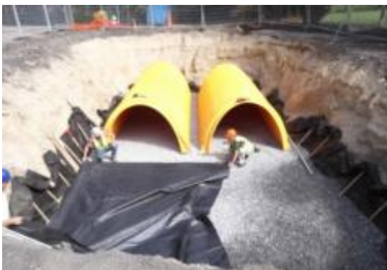
ภาพที่ 2.3 การออกแบบพื้นที่แบบโพรงใต้ดิน (Underground Chambers)
