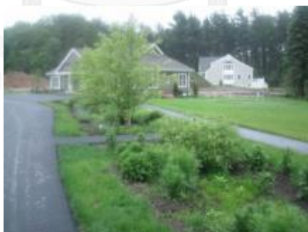
ภาพที่ 2.10 การพัฒนาพื้นที่ด้วยระบบหลุมต้นไม้ (Bioswales)
