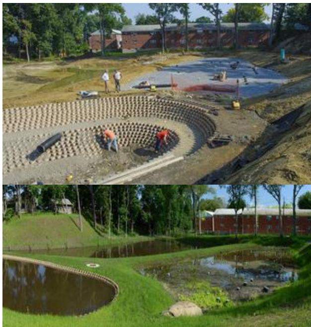
ภาพที่ 6.3 การพัฒนาพื้นที่กักเก็บน้ำแบบใช้พืชพรรณ (Bioretention) มหานครนิวยอร์ก ที่มา: Gruber, 2013
