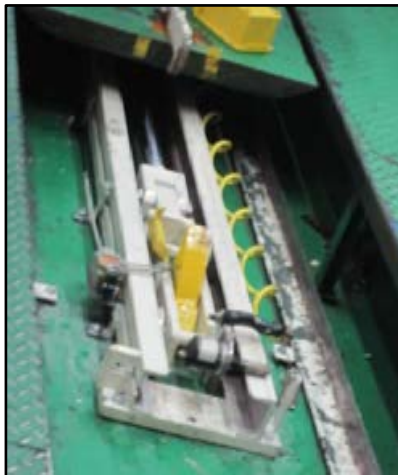
รูปที่ 4.4 หลังการติดตั้งระบบอัตโนมัติ
