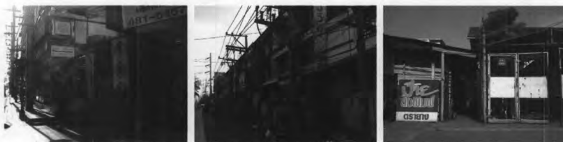
รูปภาพที่ 3.13 : แสดงภาพถ่ายสภาพอาคารในบริเวณพื้นที่บริเวณแยกลำสาลี
