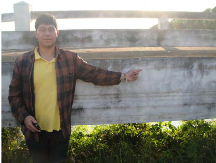
รูปที่ 3.28 ภาพถ่ายแสดงลักษณะร่องรอยของน้ำท่วม (Water mark) ถ่ายไปทาง E
