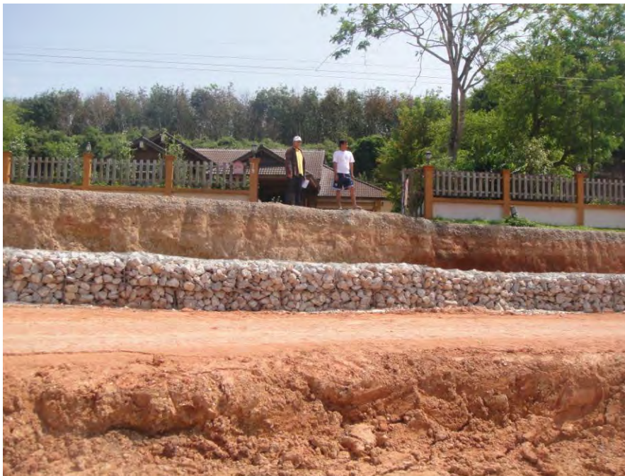
รูปที่ 3.19 ภาพถ่ายแสดงลักษณะลำดับการกัดเซาะของแม่น้ำ ถ่ายไปทาง SE
