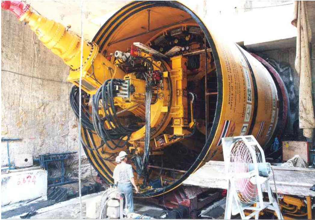
รูปที่ 3.17 แสดงการประกอบ TBM ที่บริเวณตำแหน่งช่องเปิดของสถานี
