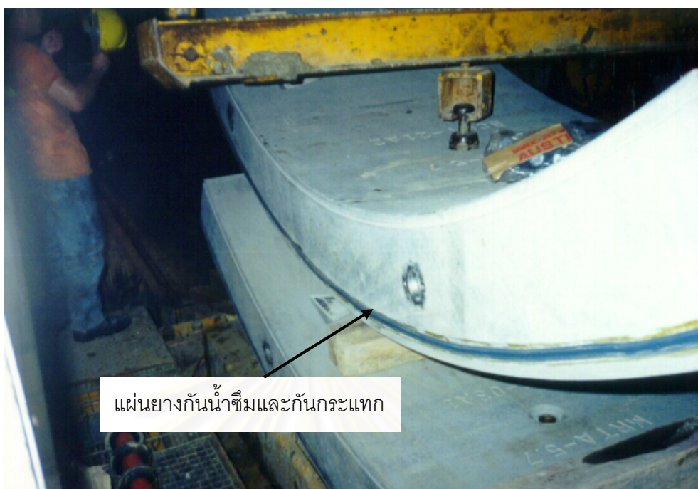
รูปที่ 3.28 แสดงแผ่นยางกันน้ำซีมและกันกระแทก
