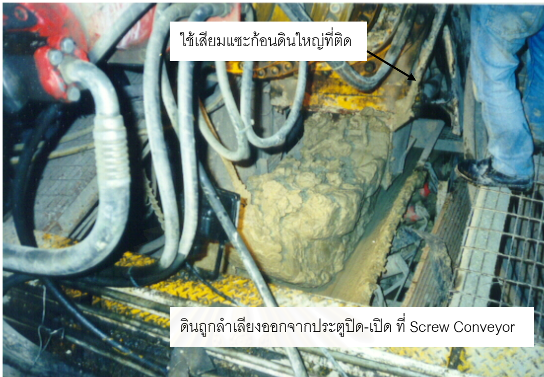
รูปที่ 3.5 แสดงดินที่ถูกลำเลียงออกมาโดย Screw Conveyor
