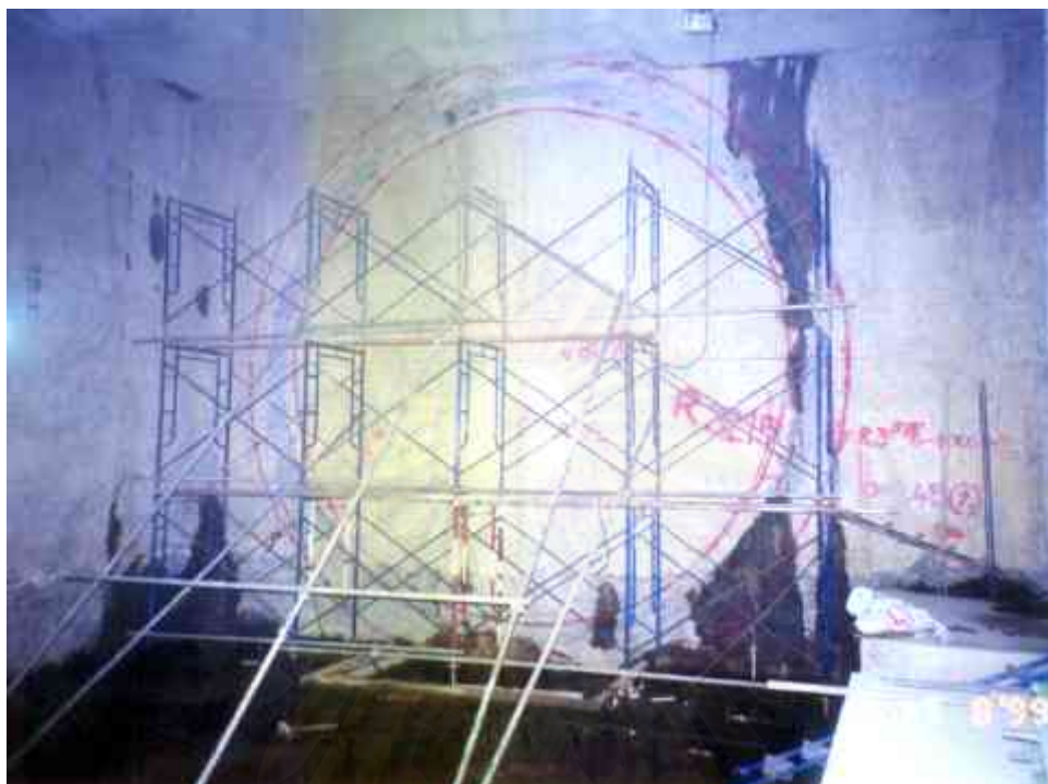
รูปที่ 3.15 แสดงตำแหน่งแนวที่จะสกัดช่องเปิดของสถานี
