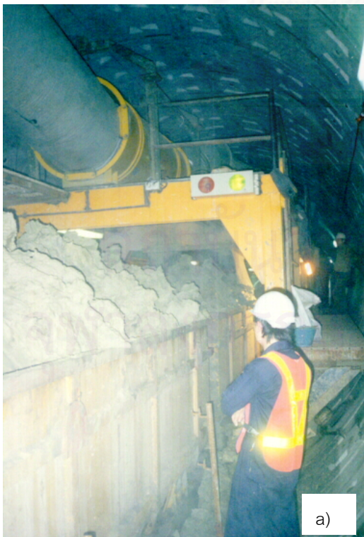
รูปที่ 3.33a,b แสดง Muck Car และ Segment Car
