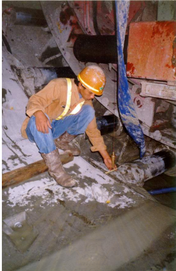
รูปที่ 3.32 วัดและตรวจสอบขนาดภายในของอุโมงค์
