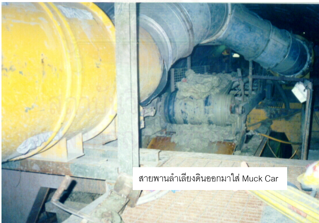
รูปที่ 3.6 แสดงดินถูกลำเลียงโดย Belt Conveyor
