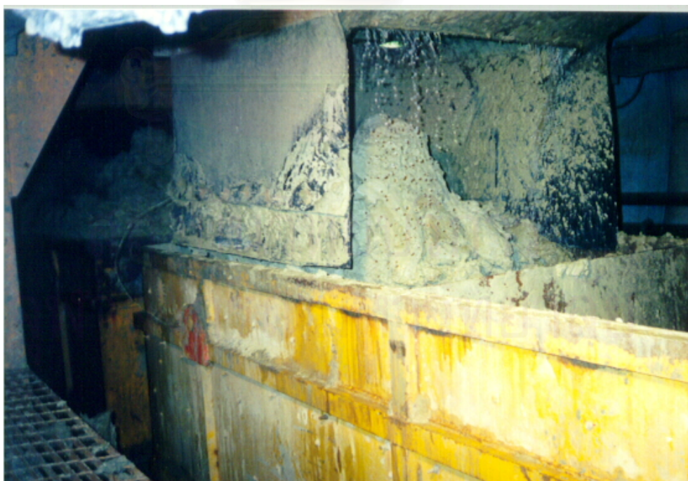
รูปที่ 3.21 ดินลงสู่ Muck Car เพื่อเตรียมขนออกไปจากอุโมงค์
