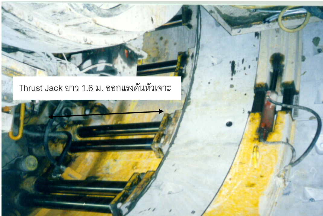
รูปที่ 3.8 แสดง Thrust Jack ที่ขับเคลื่อนหัวเจาะให้เคลื่อนที่
