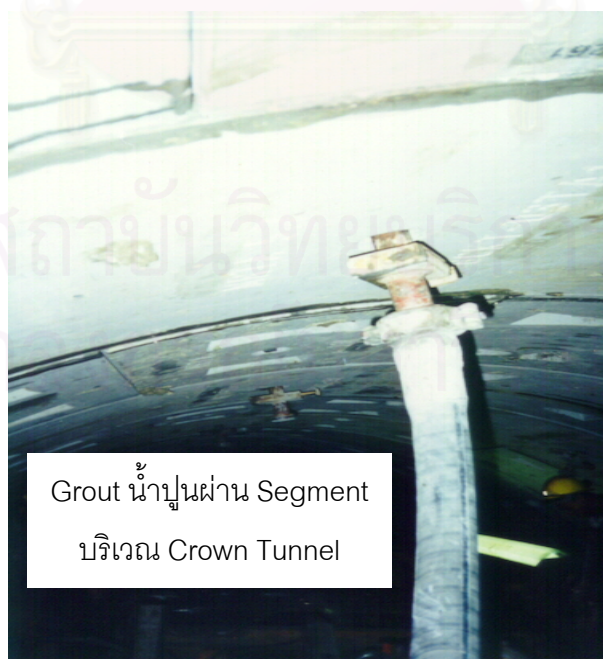
รูปที่ 3.12 แสดงการ Grout น้ำปูนผ่าน Segment
