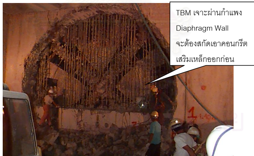
รูปที่ 3.23 แสดง TBM เจาะทะลุผ่านผนัง Diaphragm Wall ของสถานีในส่วนสายใต้
