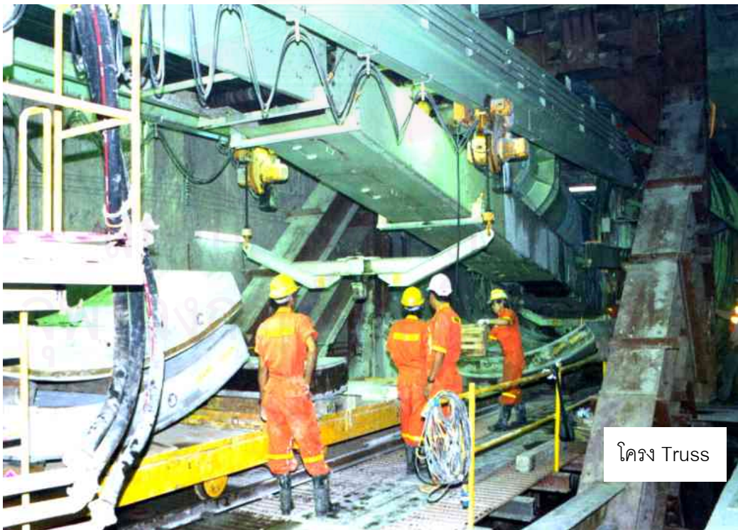
รูปที่ 3.18 แสดงการติดตั้ง TBM เพื่อเตรียมขุดเจาะ
