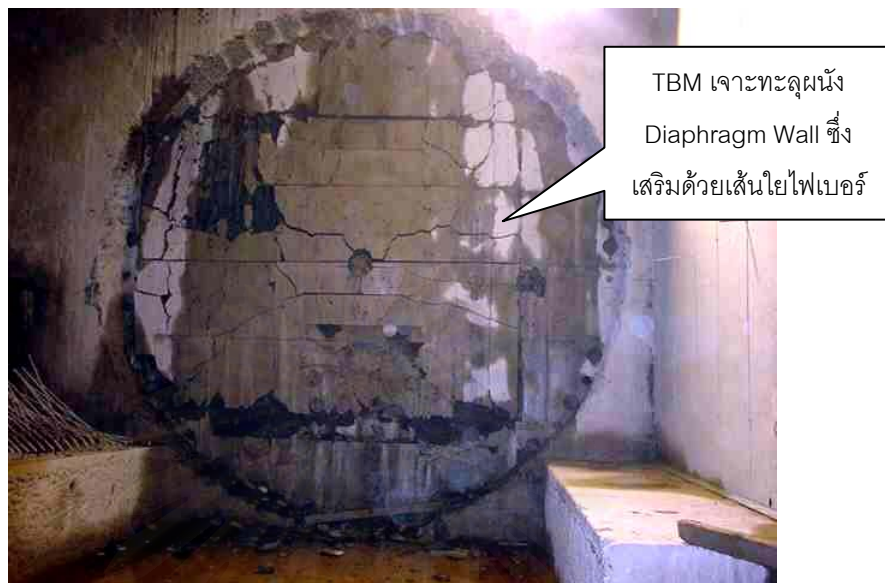
รูปที่ 3.22 แสดง TBM เจาะทะลุผ่านผนัง Diaphragm Wall ของสถานีในส่วนสายเหนือ
