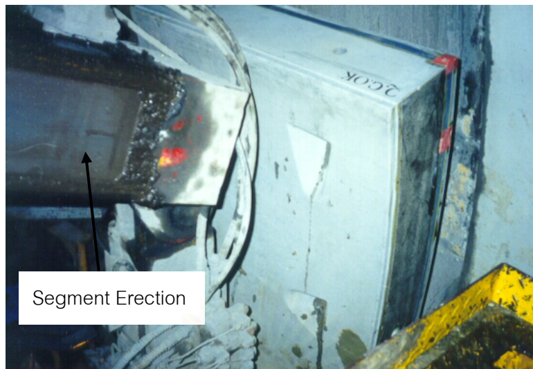
รูปที่ 3.10 แสดงเครื่องติดตั้ง Segment
