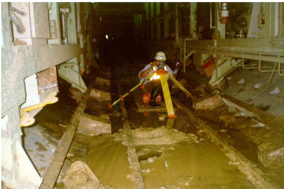
รูปที่ 3.30 แสดงการสำรวจแนวขุดเจาะอุโมงค์
