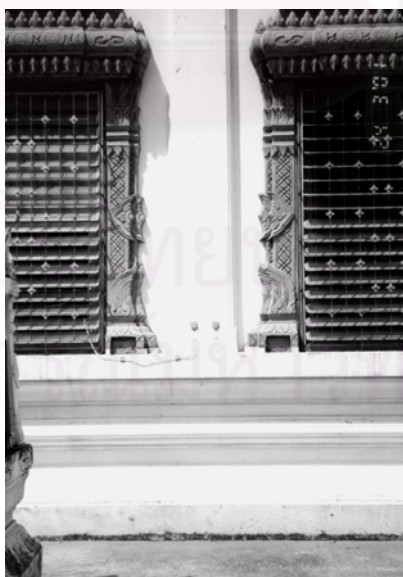
ภาพที่ 4-22 การติดตั้งหัววัดอุณหภูมิที่ผนังภายนอก
