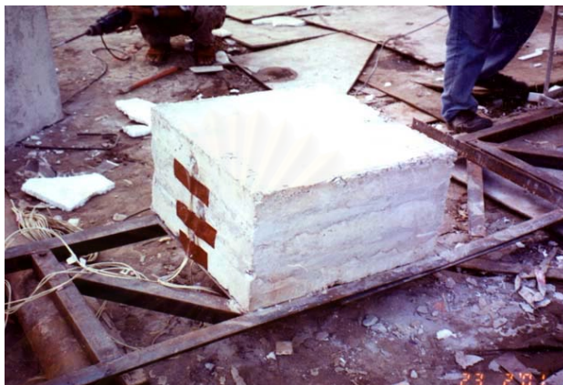
ภาพที่ 3-10 การติดตั้งและประกอบแผ่นคอนกรีต 3 ชั้น
