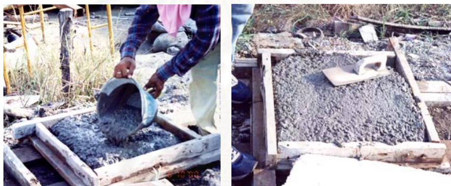
ภาพที่ 3-8 การเทคอนกรีต
