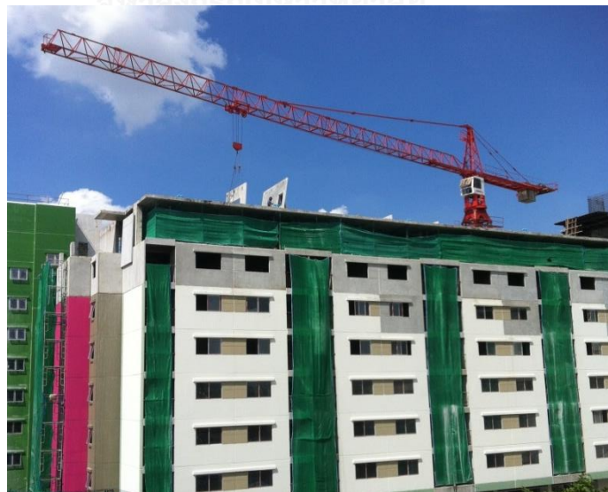
ภาพที่ 17 แสดงทาว์นเวอร์เครนที่ใช้ในโครงการระยะการทำงานโดยรอบอาคารโครงการที่ 1
