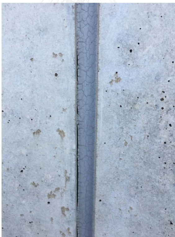
รูปที่ 3. 9 ลักษณะการพังเนื่องจากอุณหภูมิ (Withit)
