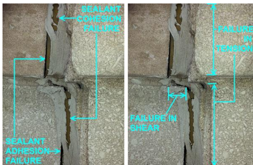
รูปที่ 3.12 การพังของวัสดุอุดรอยต่อด้วยแรงดึงและแรงเฉือน
