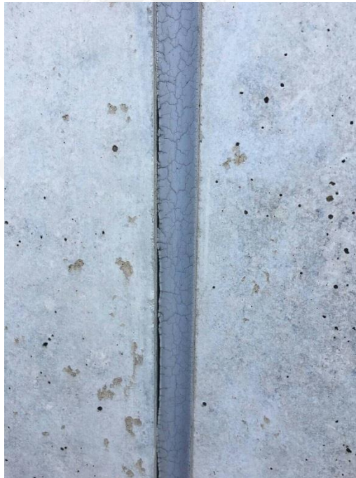
รูปที่ 2. 1 การเสื่อมสภาพของวัสดุอุดรอยต่อโพลียูรีเทน (Withit)
