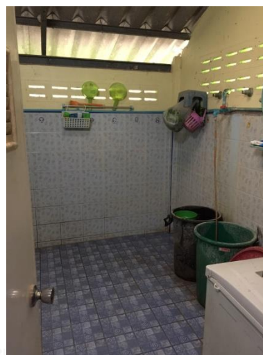
ห้องอาบน้ำ
