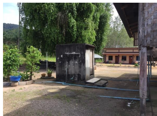
ห้องน้ำ(เดิม)ปลุกแยกจากตัวบ้าน
