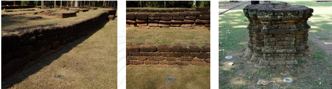
ภาพที่ 4.15 การติดตั้งดวงโคมฝังพื้นสำหรับส่องฐานอาคารและกำแพง
