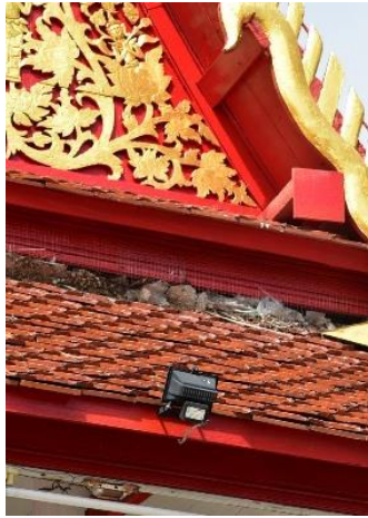
ภาพที่ 4.33 การติดตั้งดวงโคมที่พื้นที่ใกล้เคียง วัดพระนอน อ.เมือง จ.แพร่
