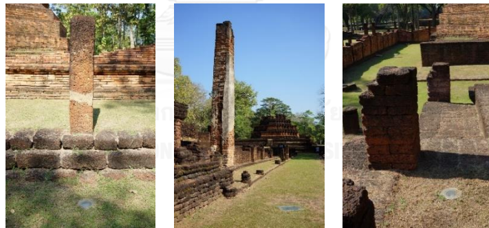
ภาพที่ 4.16 การติดตั้งดวงโคมฝังพื้นสำหรับส่องเน้นส่วนของผนังที่มีความสูง
