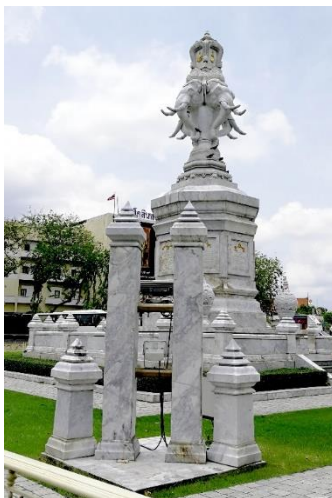
ภาพที่ 4.26 การออกแบบเสาสำหรับติดตั้งดวงโคมส่องซุ้มเฉลิมพระเกียรติกาญจนาภิเษก กรุงเทพฯ
