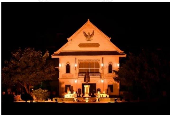
ภาพที่ 4.71 มุมมองด้านหน้าของพิพิธภัณฑสถานแห่งชาติน่าน (ภาพถ่ายก่อนการบูรณะ ถ่ายเมื่อ 1 กรกฎาคม พ.ศ. 2558)
