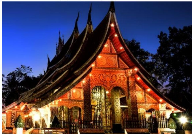
ภาพที่ 4.32 การติดตั้งดวงโคมประดับหน้าบันที่โครงสร้างหลังคา วัดเชียงทอง เมืองหลวงพระบาง สปป.ลาว
