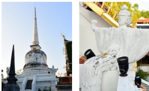
ภาพที่ 4.38 การติดตั้งดวงโคมที่ชั้นฐานเพื่อส่องเน้นองค์ระฆัง เจดีย์ราย วัดพระมหาธาตุฯ จ. นครศรีธรรมราช
