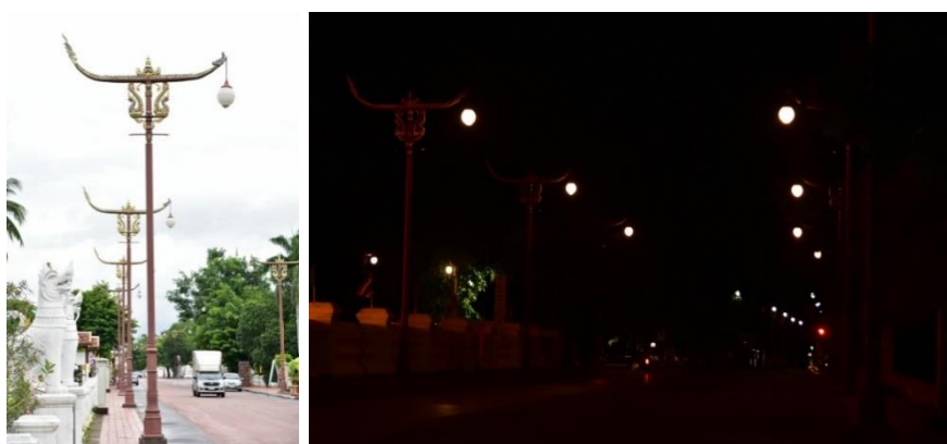
ภาพที่ 4.77 รูปแบบดวงโคม (ซ้าย) แสงสว่างในเวลากลางคืนบนถนนผากอง (ขวา)
