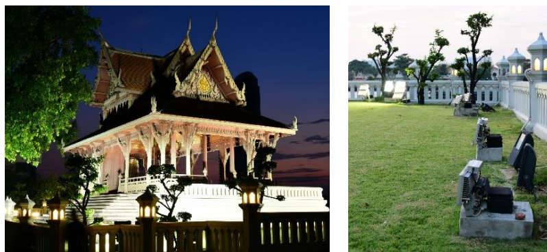
ภาพที่ 4.21 การติดตั้งดวงโคมบนพื้นเพื่อสอดส่องทั้งอาคาร (Floodlighting)
