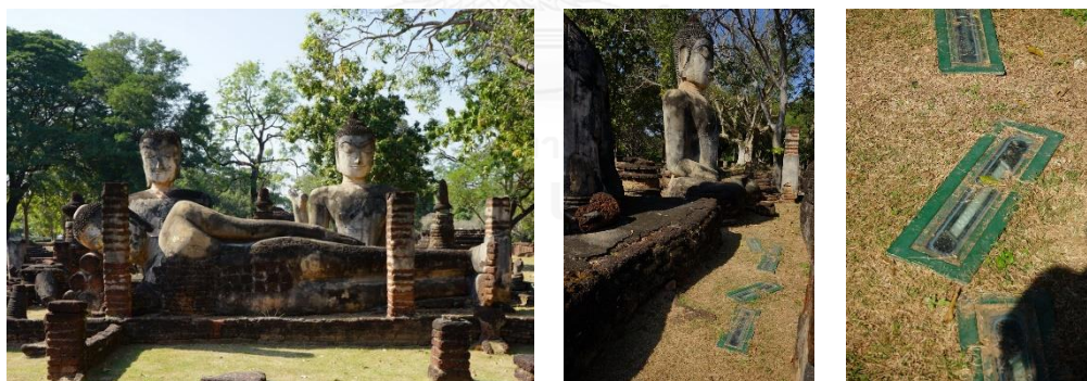
ภาพที่ 4.14 รูปแบบการติดตั้งดวงโคมสำหรับส่องพระพุทธรูปที่ประดิษฐานรวมกันเป็นกลุ่ม
