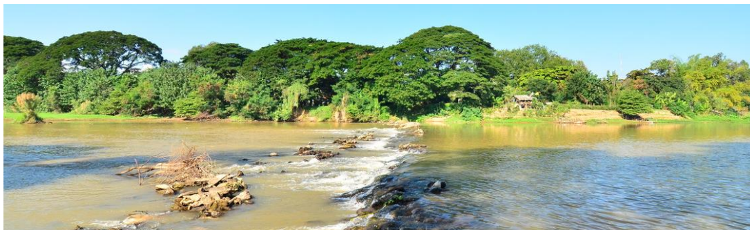
ภาพที่ 3 - 1 ฝายพญาคำทำหน้าที่ยกระดับน้ำในแม่น้ำปิงให้สูงขึ้นก่อนจะผันน้ำเข้าสู่ลำเหมืองพญาคำต่อไป
