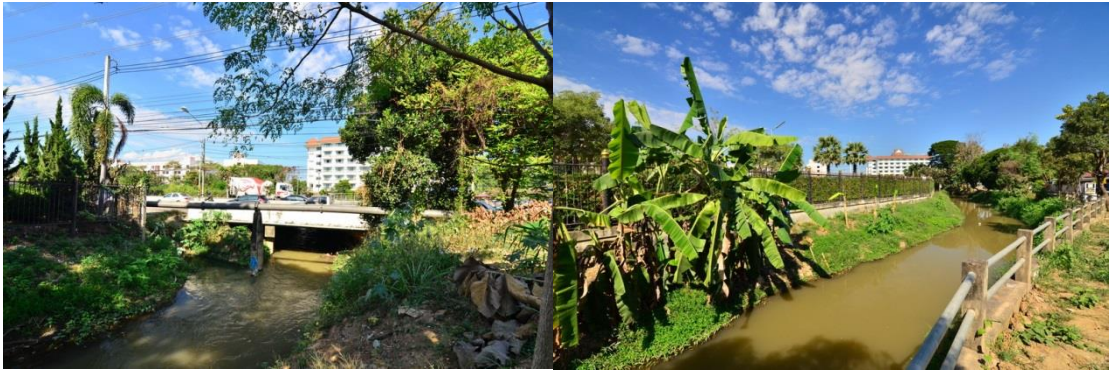
ภาพที่ 5 - 17 สภาพปัจจุบันของลำเหมืองพญาคำ บริเวณจุดตัดถนนวงแหวนรอบ 1 ต.หนองหอย อ.เมือง จ.เชียงใหม่ ที่มา: ภาพจากการลงพื้นที่สำรวจเมื่อวันที่ 21 ธันวาคม 2559
