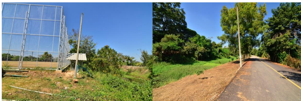
ภาพที่ 5 - 24 สภาพปัจจุบันของลำเหมืองพญาคำบริเวณพื้นที่ ต.อุโมงค์ อ.เมือง จ.ลำพูน ที่มา: ภาพจากการลงพื้นที่สำรวจเมื่อวันที่ 22 ธันวาคม 2559
