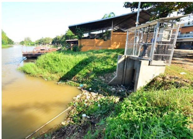
ภาพที่ 3 - 3 ประตูลำเหมืองพญาคำ รับน้ำจากฝายพญาคำ ปัจจุบันถูกปรับเปลี่ยนเป็นประตูคอนกรีต และมีระบบควบคุม ที่มา: ภาพจากการสำรวจเมื่อวันที่ 21 ธันวาคม 2559
