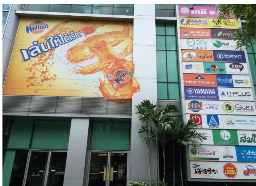
รูปภาพที่ 4. 9 ด้านหน้าของอาคารวรรณสรณ์ พญาไท
