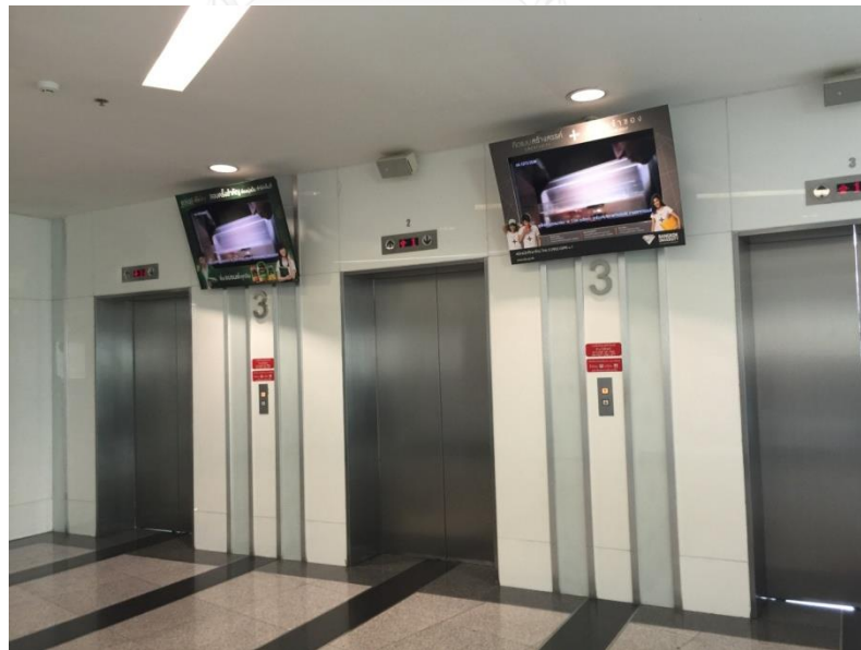
รูปภาพที่ 6. 17 ลิฟต์ภายในอาคาร
