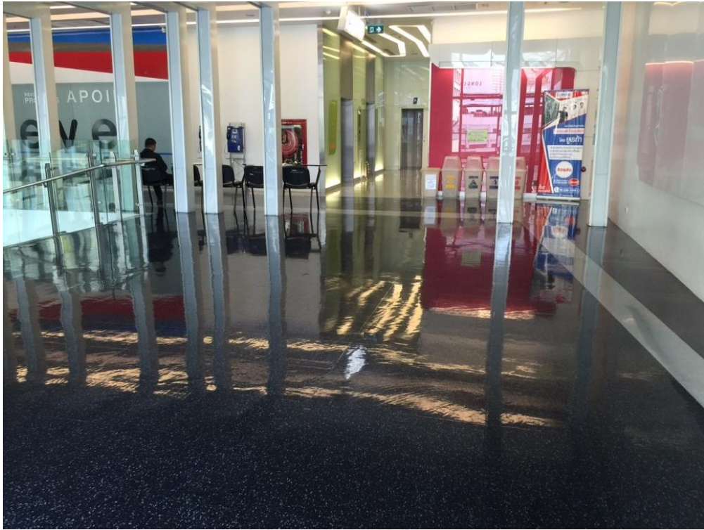
รูปภาพที่ 6. 3 ก่อนการปรับปรุงพื้นที่
