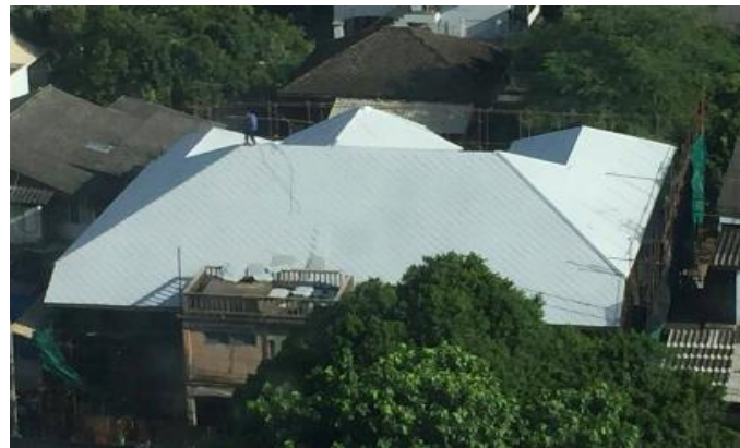
ภาพที่ 24 (บน) หลังคากระเบื้องว่าวของบ้านหัวลำโพงก่อนการบูรณะ (ล่าง) หลังคากระเบื้องว่าวของบ้านหัวลำโพงหลังการบูรณะ ที่มา: ชุติมา วรมนตรี (2559)
