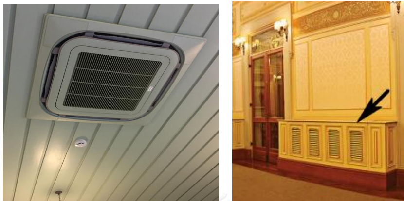
ภาพที่ 49 ตัวอย่างการติดตั้งเครื่องปรับอากาศอาคารบ้านเลขที่ 1 ซอยกัปตันบุชและวังพญาไท
