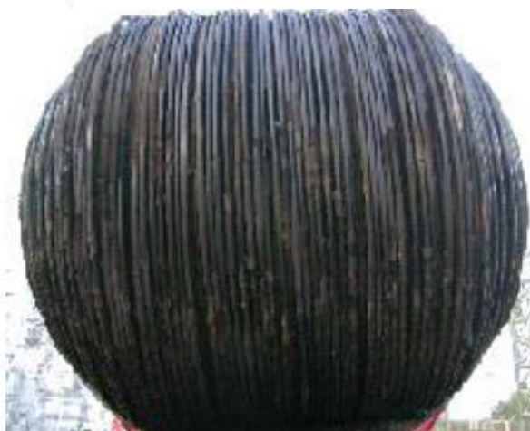
รูปที่ 1.2 การเกิดตะกรันบนผิวของหม้อต้มไอน้ำ 2100-E3
