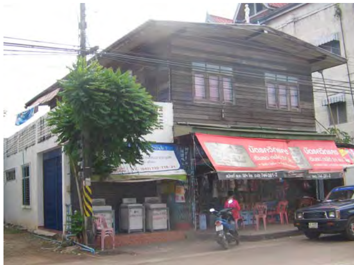
รูปที่ 15 ลักษณะโครงสร้างของร้าน ข.
