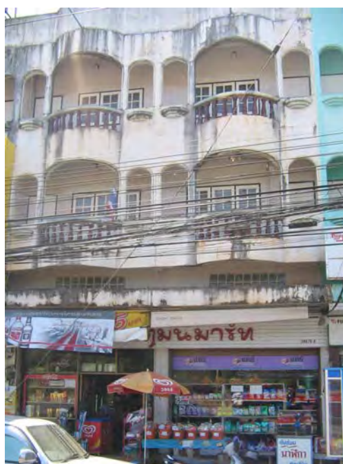
รูปที่ 20 ลักษณะโครงสร้างของร้าน ค.
