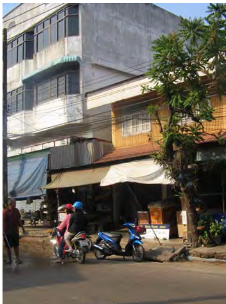
รูปที่ 11 ลักษณะโครงสร้างของร้าน ก.
