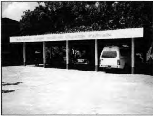
ภาพที่ 5.8 อาคารจอดรถถาวร
