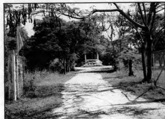
ภาพที่ 5.5 ถนนดินโรยกรวดต่อกับถนน ค.ส.ล.
