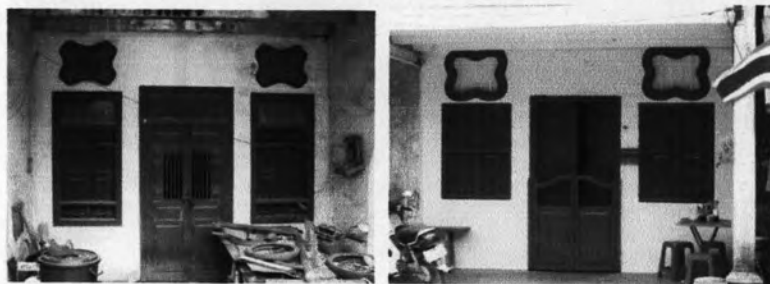
ลักษณะประตูบานเปิด 2 ชั้น หน้าต่างและช่องแสงเหนือหน้าต่างของอาคารชั้นล่าง
