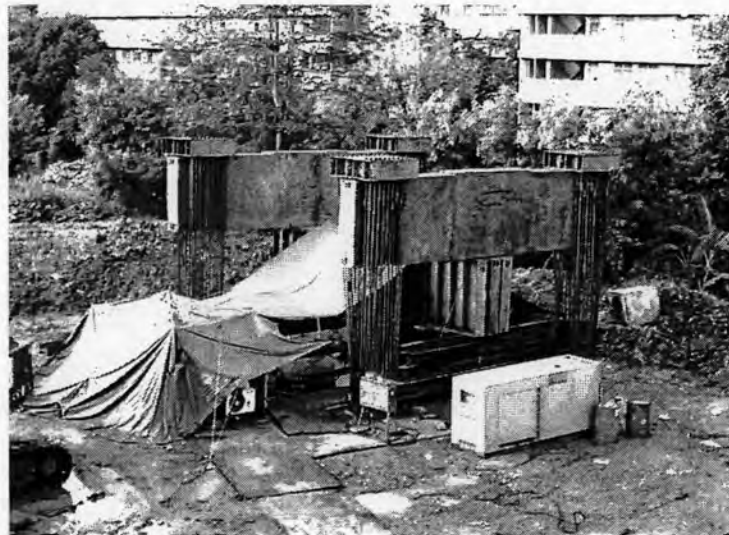
รูปที่ 2.6 แสดงการทดสอบกำลังรับน้ำหนักบรรทุกของเสาเข็มแบบสถิตศาสตร์
