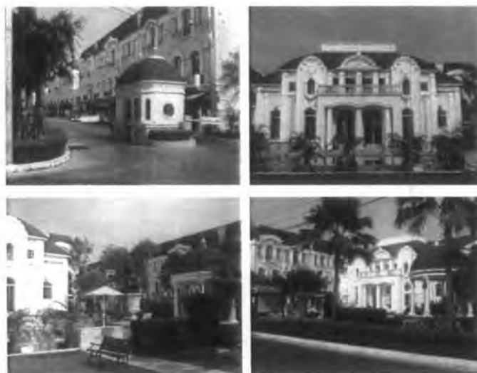
ภาพที่ 3.2 สภาพหมู่บ้านจัดสรร กรณีศึกษา A
