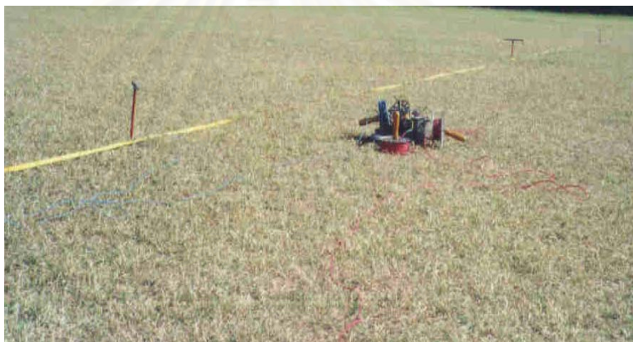
รูปที่ ก3 การวัดค่าความต้านทานดินที่ระยะ 7.5 เมตร
