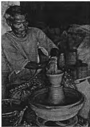
รูปที่ 1.14 วิธีการขึ้นรูปถ้วยน้ำชาข่างพาด้วยเป็นหมุนและผลิตภัณฑ์ ของโรงงานตั้งเจริญ ตำบลท่าใหม่ อำเภอบำเหน็จ จังหวัดจันทบุรี
