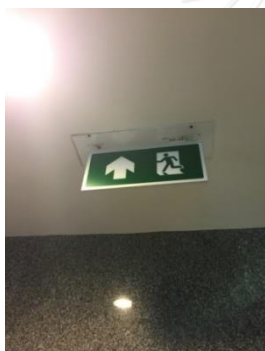
รูปที่ 30 ระบบไฟฟ้าแสงสว่างฉุกเฉิน
