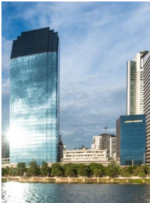
รูปที่ 5 อาคารเลครัชดา ออฟฟิศ คอมเพล็กซ์
