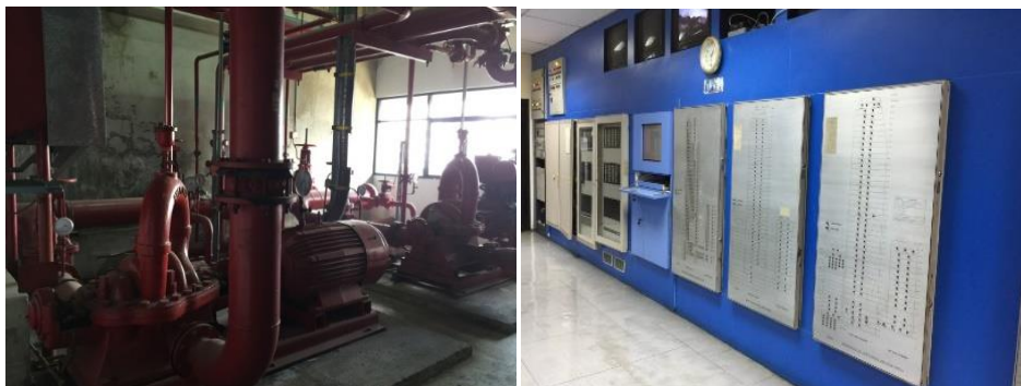
รูปที่ 31 ระบบป้องกันอัคคีภัยและแจ้งเหตุเตือนภัย
