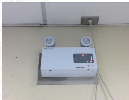
รูปที่ 30 ระบบไฟฟ้าแสงสว่างฉุกเฉิน
