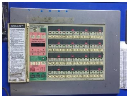
รูปที่ 29 ระบบไฟฟ้าแสงสว่าง
