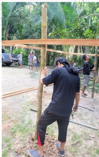
ภาพที่ 86 เสารอบโรงกาหลอที่ลงหลุมแล้ว ที่มาภาพ : ปานตา ศรีคง วันอาทิตย์ที่ 19 มีนาคม 2560
