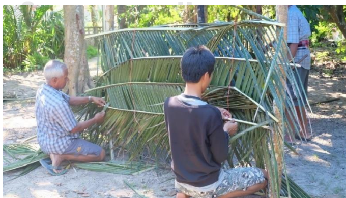
ภาพที่ 90 การมัดทางมะพร้าวทำเป็นผนัง
