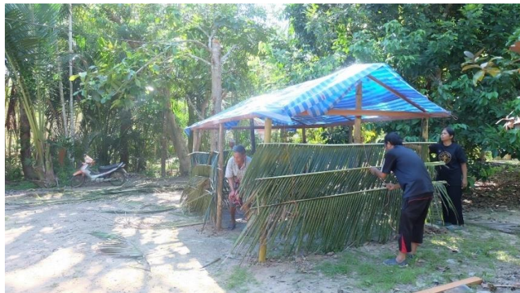
ภาพที่ 91 การมัดทางมะพร้าวทำเป็นผนังทั้ง 4 ด้าน ที่มาภาพ : ปานตา ศรีคง วันอาทิตย์ที่ 19 มีนาคม 2560
