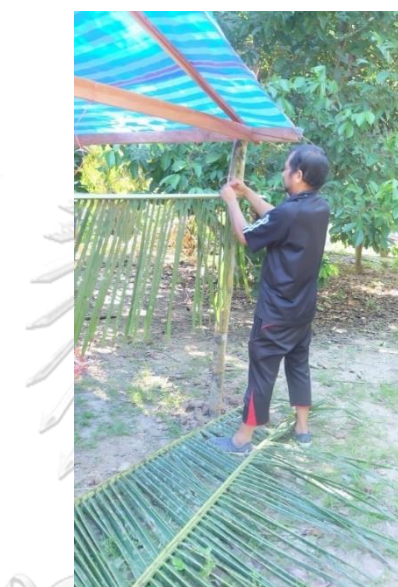
ภาพที่ 89 การมัดทางมะพร้าวทำเป็นผนัง
