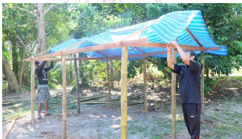
ภาพที่ 88 ใช้ผ้าใบซึ่งเป็นหลังคาด้านบน ที่มาภาพ : ปานตา ศรีคง วันอาทิตย์ที่ 19 มีนาคม 2560
