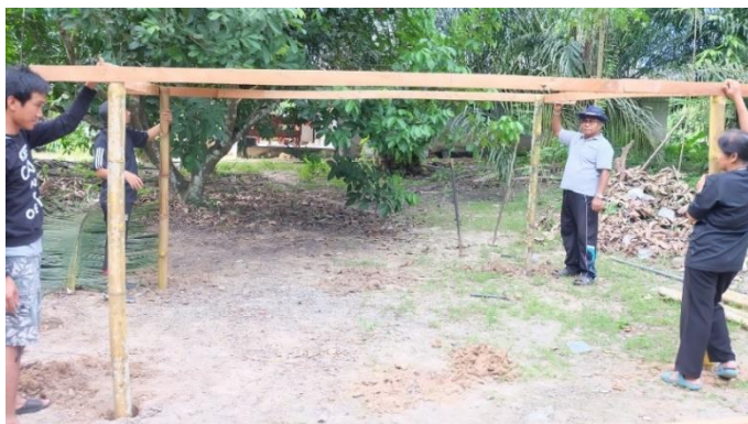
ภาพที่ 85 เสารอบโรงกาหลอที่ลงหลุมแล้วนำซี่วางเพื่อยึดเสากับซี่ด้วยตะปู ที่มาภาพ : ปานตา ศรีคง วันอาทิตย์ที่ 19 มีนาคม 2560
