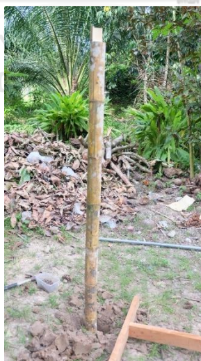
ภาพที่ 84 เสารอบโรงกาหลอที่ลงหลุมแล้ว
