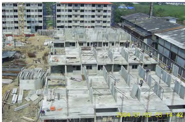
ภาพที่ 6.12 แสดงการติดตั้งผนังสำเร็จรูป
