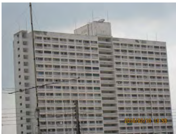
ภาพที่ 5.1 คอนโดมิเนียมสูง 19 ชั้น โครงการพญา
