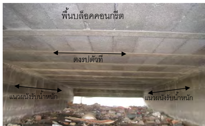
ภาพที่ 4.12 แสดงการวางพื้นคอนกรีตบล็อก
