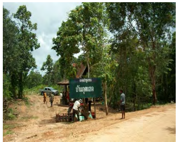
การซ่อมแซมป้ายเขตป่าชุมชนบ้านกุดแฮด
